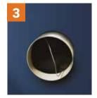
Inserire tubo telescopico con filtri e scambiatore termico in ceramica.
