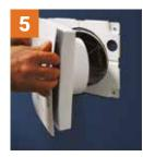
Agganciare il pannello interno con sistema di fissaggio magnetico alla placca di fissaggio e dare alimentazione alla VMC.
